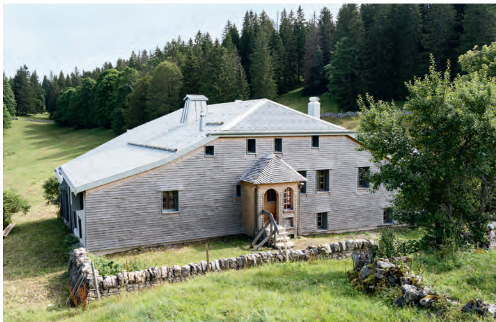
Vue de la ferme des Mollards-des-Aubert, façade sud-ouest et son porche d'entrée, été 2024. Photo Liubov Krivenkova.
